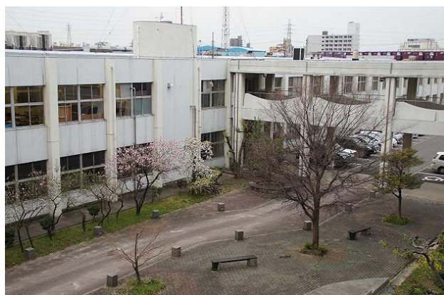
やすらぎ広場と実習棟
