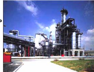
圧力容器が多用される石油精製プラント 〔出所: コスモ石油〕
