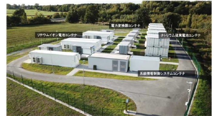
【写真】 ファーレル変電所におけるハイブリッド蓄電池システム外観
